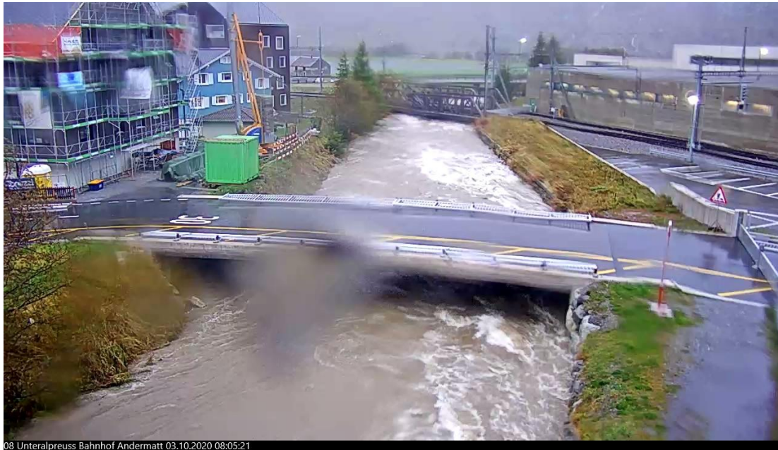
Bahnhofstrassenbrücke und Bahnhofsbrücke
